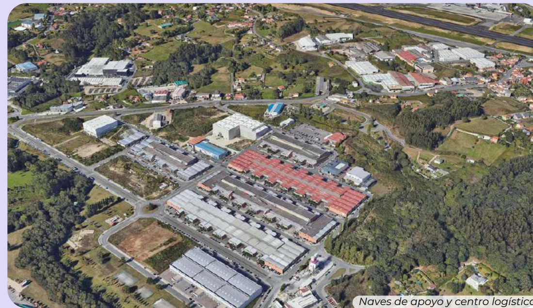
Naves de apoyo y centro logístico
