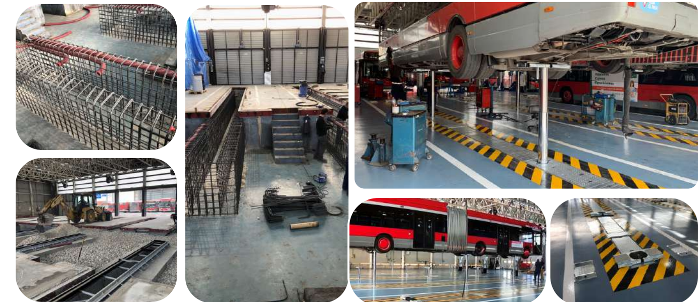
OBRAS DE MANTENIMIENTO PARA EL SERVICIO PÚBLICO DE TRANSPORTE DE VALENCIA
